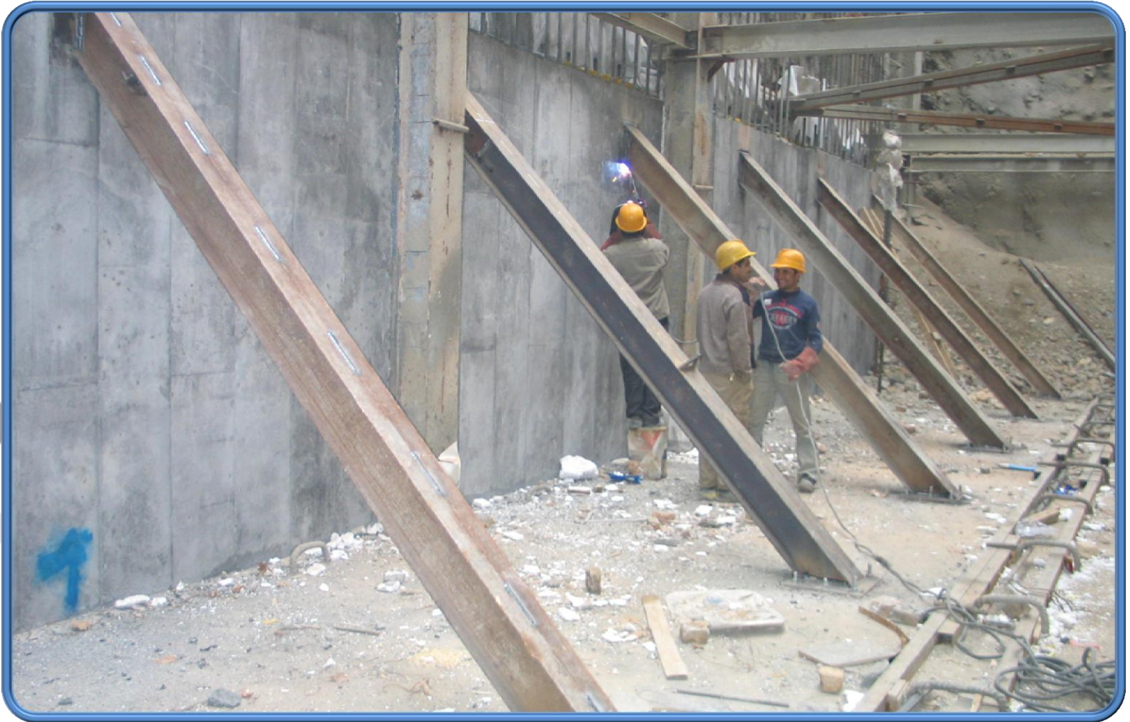
عکس شماره (۴۹) - دستکهای مورب تقویت دیوار بتنی
