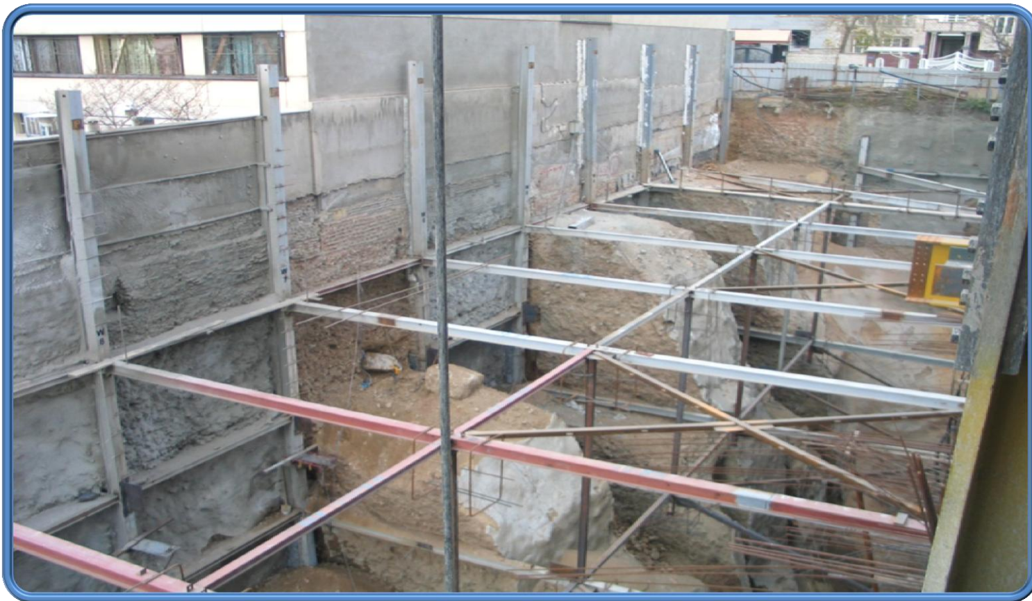
عکس شماره ۴۳ - برخورد با قلوه سنگهای بزرگ در حفاری یکی از برمهای شمال غربی گود
