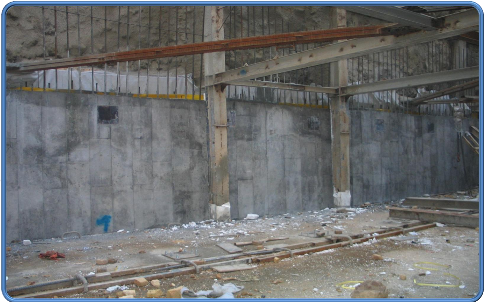
عکس شماره ۴۸ - نمایی از دیوار بتنی واقع در ضلع جنوب گود
