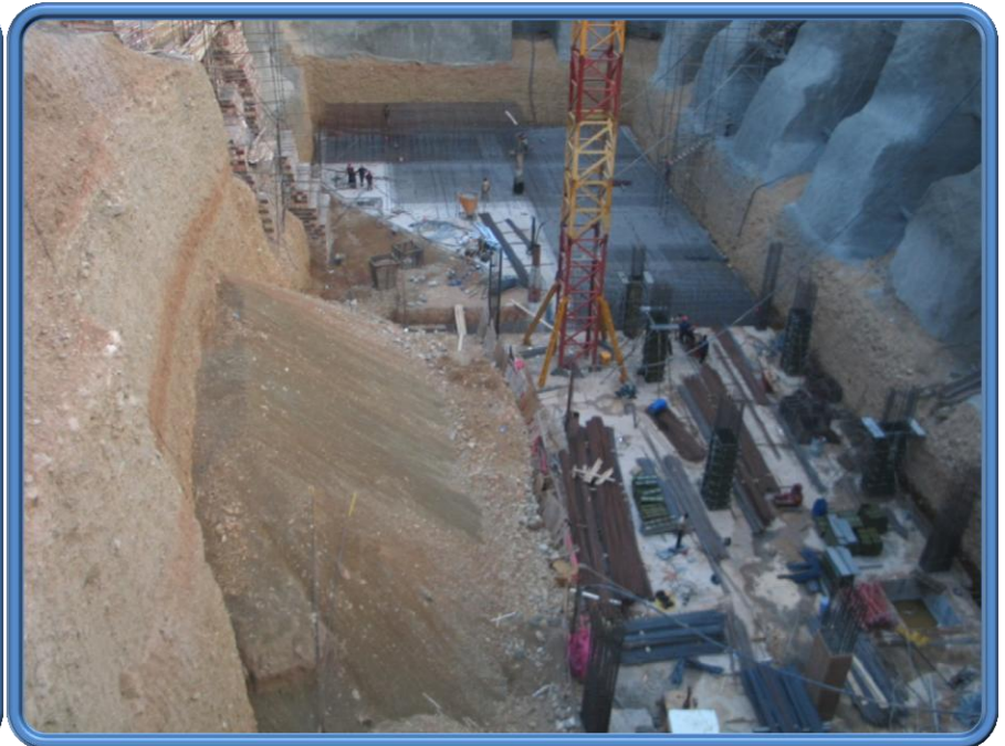
عکس شماره (۵۳) - ریزش در دیواره خاکی بدلیل عدم رعایت شیب پایدار
