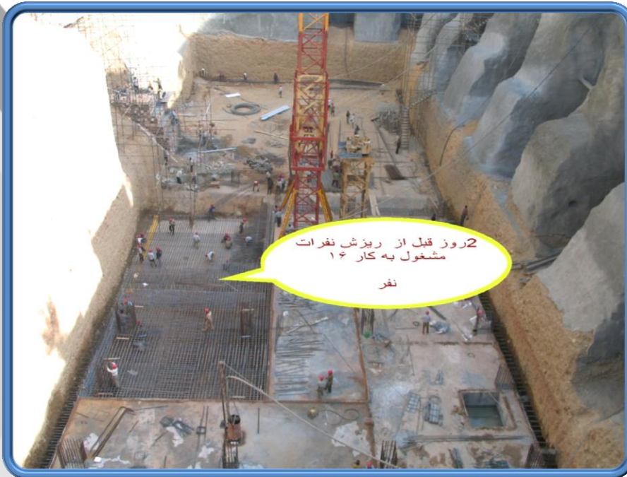
عکس شماره (۵۳) - ریزش در دیواره خاکی بدلیل عدم رعایت شیب پایدار
