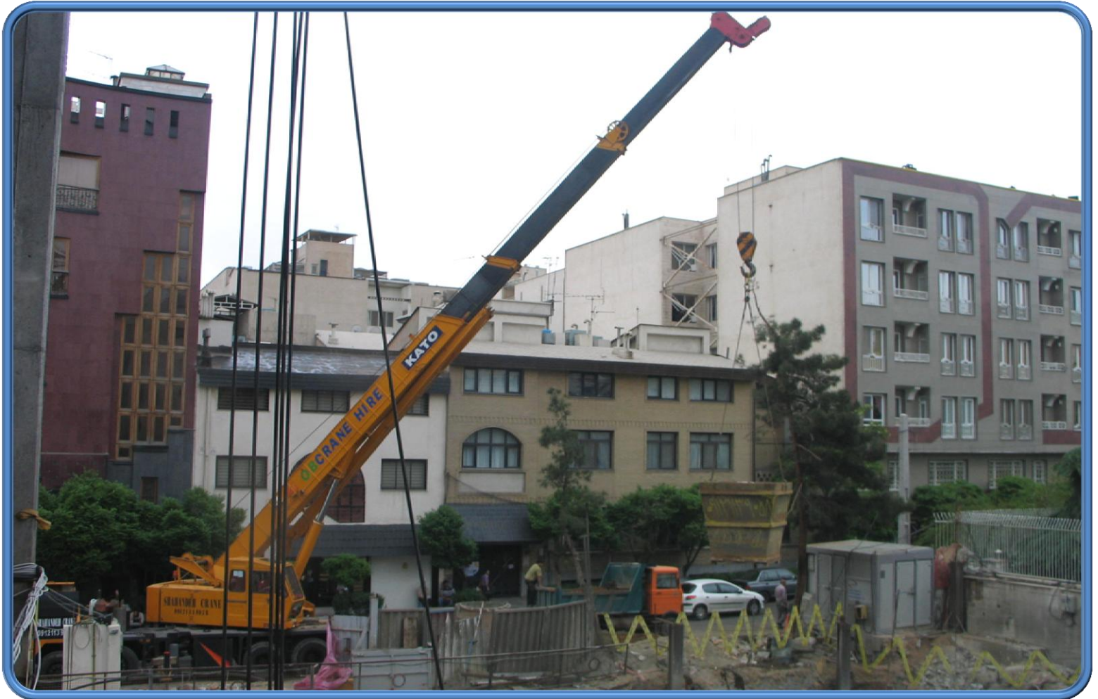
عکس شماره ۵۷ - مکانیزم حمل خاک با استفاده از جرثقیل و یک لودر
