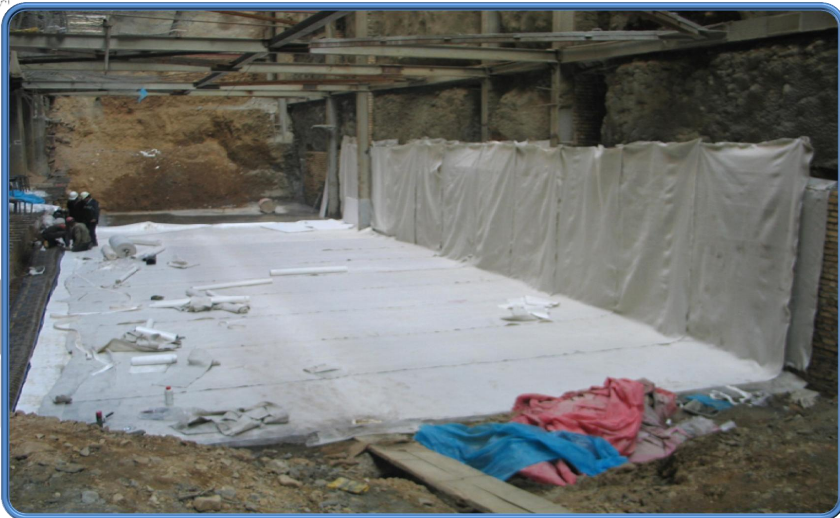
عکس شماره ۴۷ - آب بندی کف با استفاده از سیستم ژئوکامپوزیت
